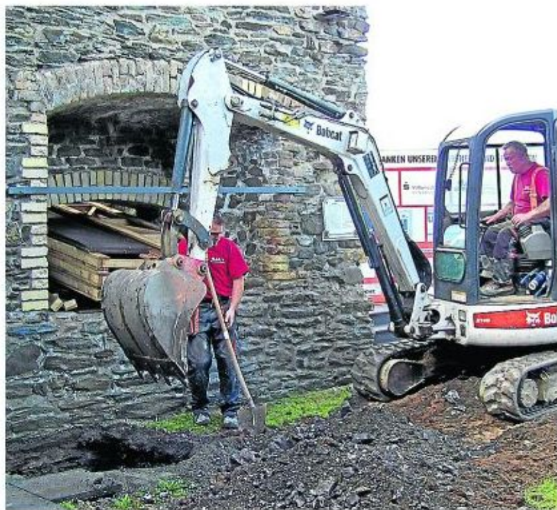
Mit einem kleinen Bagger wurden die Vorarbeiten geleistet, damit dort der Beton eingefüllt werden konnte.
